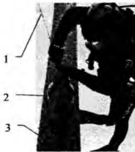
Рис. 7.17. Варіант застосування зарядів КЗ-5 при руйнуванні залізобетонної балки
